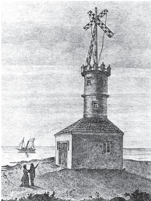
Рис. 13 Башня семафорного телеграфа на берегу Черного моря (рисунок выполнен в 1886 г. по сохранившимся частям постройки)
