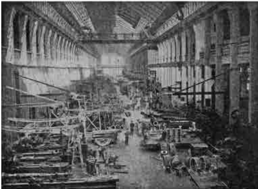
Рис. 5. Завод ЭТЦР в Харькове. Сборный цех крупных машин
