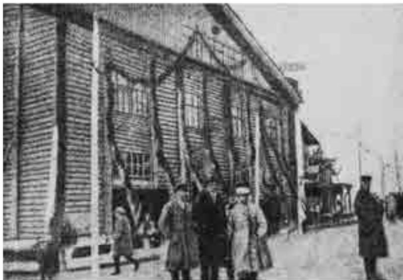
Рис. 2. Шунгенская электрическая станция
