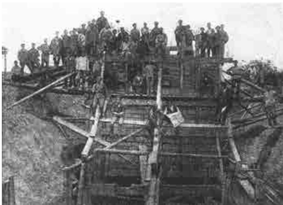
Рис. 8. Ивановская гидроэлектрическая станция. Сооружение здания
