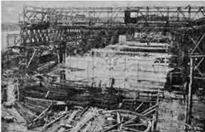
Рис. 1. Волховстрой. Котлован здания
