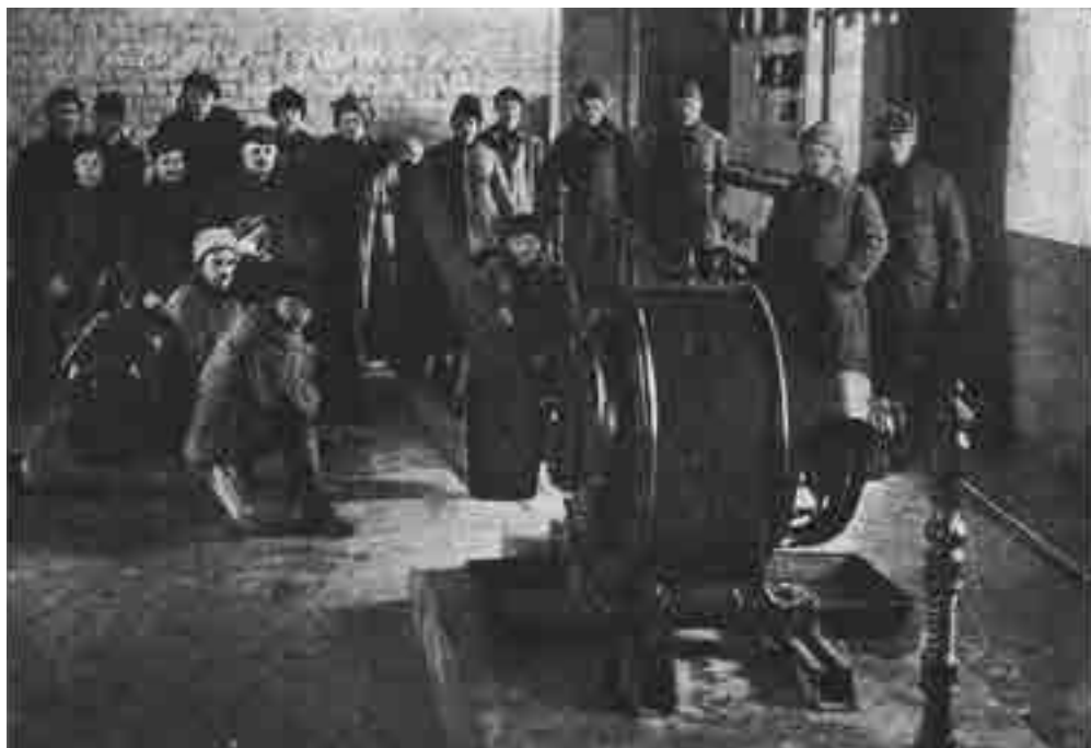
Рис. 14. Спасская центральная электрическая станция. Генератор, уравниватель и распределительное устройство
