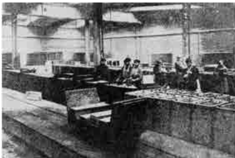
Рис. 20. Формация аккумуляторных пластин
