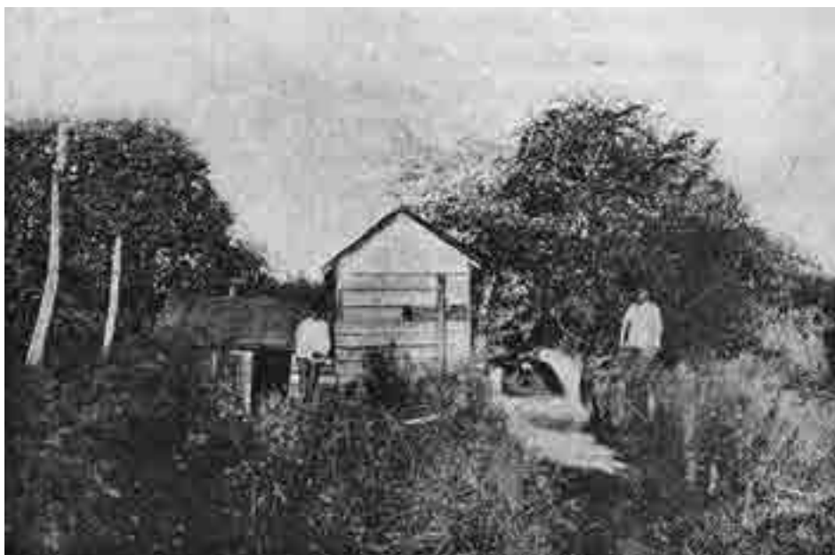
Рис. 8. Электроводокачка для орошения полей в Тимашевском совхозе Самарской губернии
