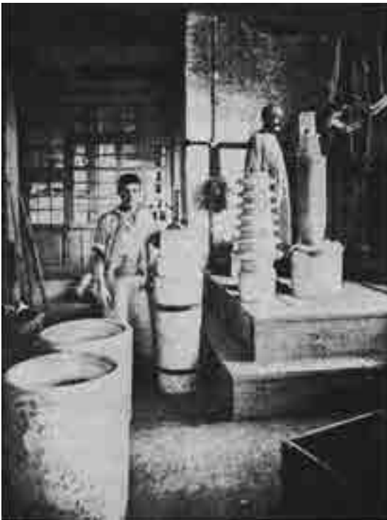
Рис. 11. Завод «Изолятор» ЭТЦР в Москве. Точка высоковольтного изолятора из целого комка
