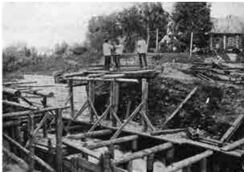
Рис. 11. Северская гидроэлектрическая станция
