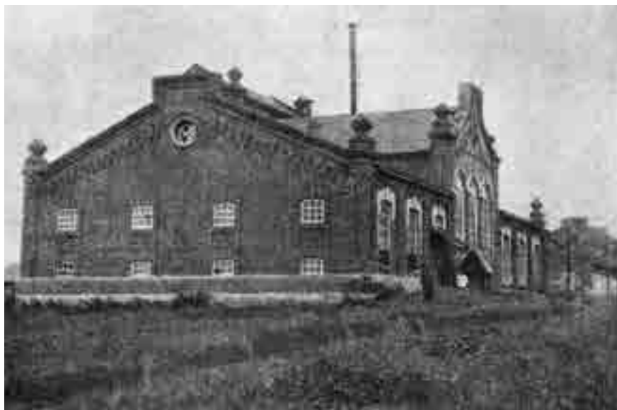
Рис. 12. Рузаевская электрическая станция
