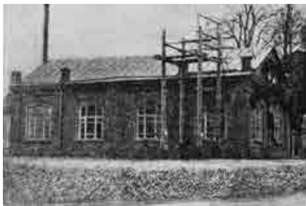
Рис. 3. Миленковская электрическая станция
