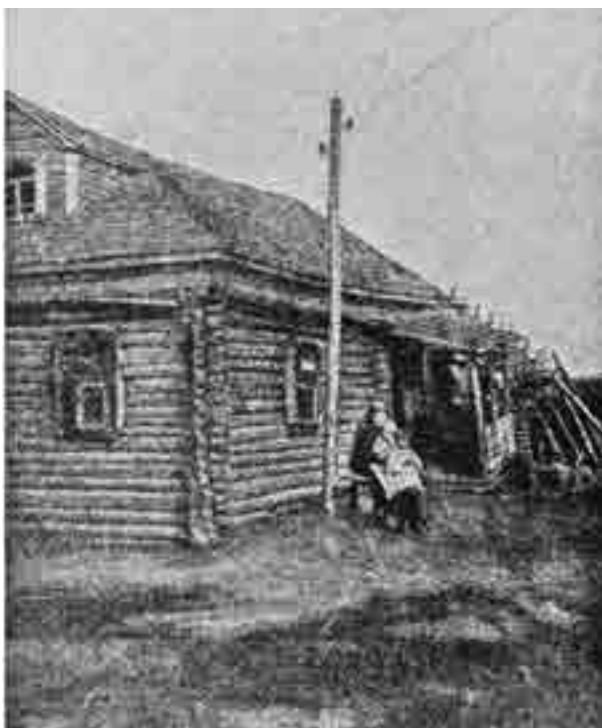
Рис. 5. Ввод электричества в избу
