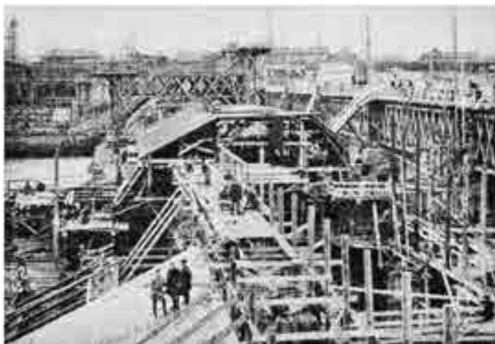
Рис. 3. Волховстрой. Сооружение плотины
