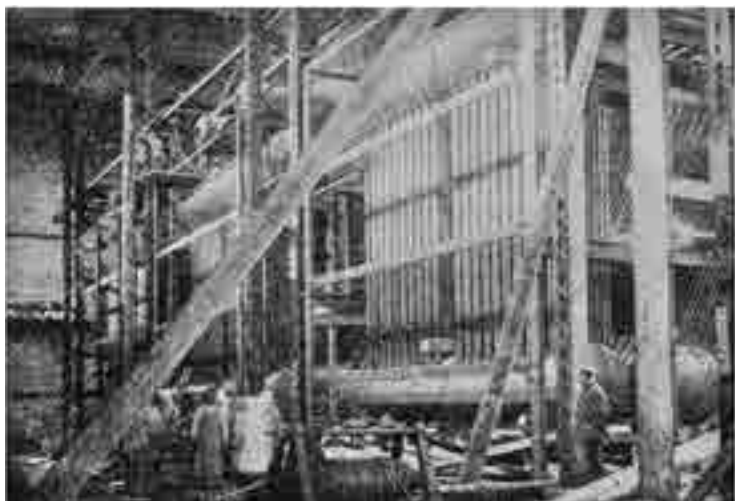
Рис. 10. Шатурская электрическая станция. Установка котлов в котельной № 1
