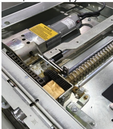
Рис.1.21 Электропривод КВЭ
