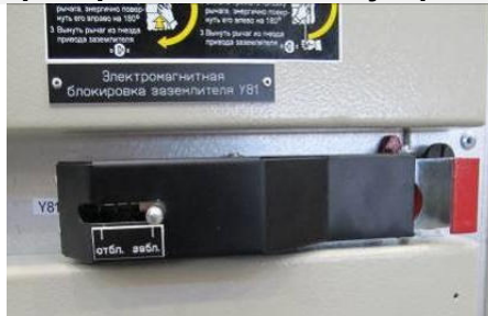
Рис. 1.37 Электромагнитная блокировка заземлителя
