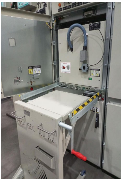
Рис. 2.18 Стыковка и фиксация сервисной тележки
