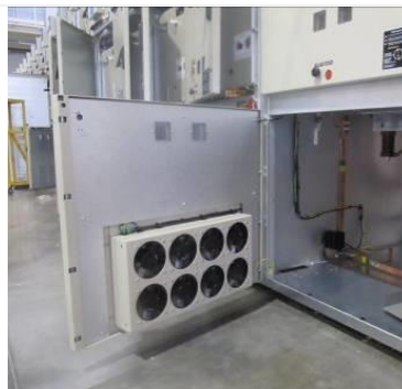
Рис. 1.54 Принудительная приточная вентиляция
