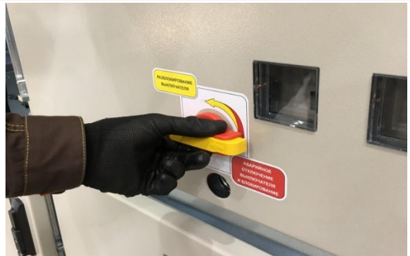
Рис. 2.25 Ручное отключение выключателя □D с фасада шкафа
