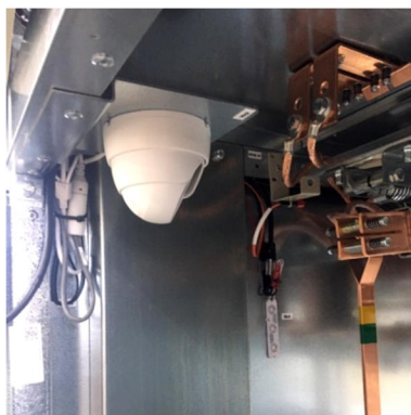
Рис. 1.50 Комбинированная защита от дуговых замыканий (клапанная и оптическая) в отсеке сборных шин
