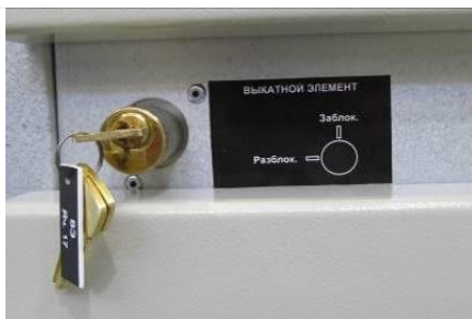
Рис. 1.38 Замковая блокировка перемещения КВЭ
