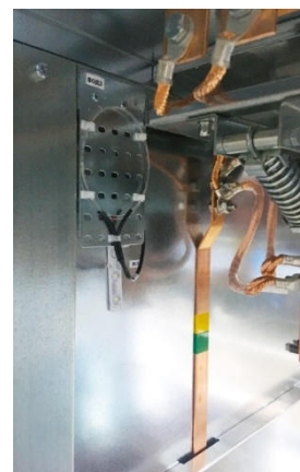
Рис. 1.51 Оптический датчик в отсеке присоединений
