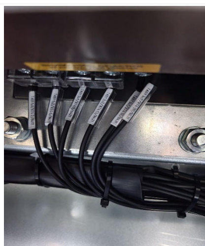
Рис. 3.9 Подключение вспомогательных цепей к ТТ
