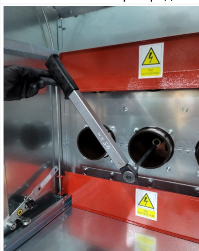
Рис. 3.8 Демонтаж контактов (пример)
