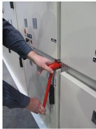
Рис. 2.9 Включение заземлителя присоединений
