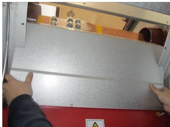
Рис.3.4 Организация доступа в отсек сборных шин с фасада шкафа
