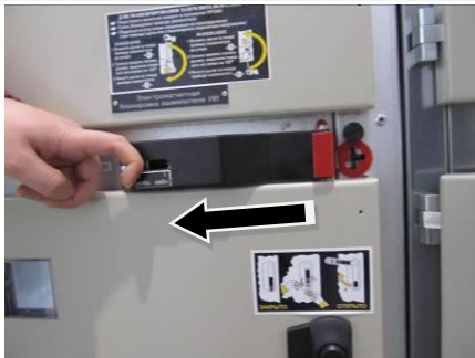
Рис. 2.6 Электромагнитная блокировка
