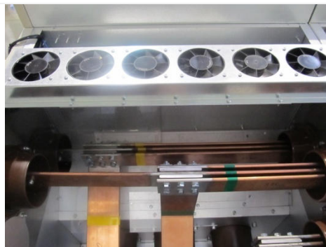
Рис. 1.55 Принудительная вытяжная вентиляция
