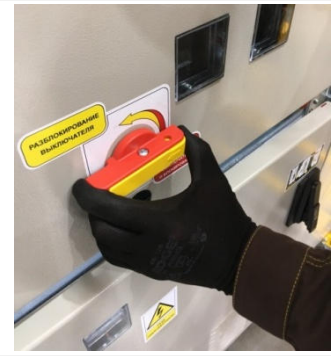
Рис. 2.5 Разблокирование вакуумного выключателя
