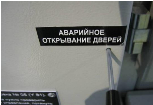
Рис. 2.22 Отверстие аварийного открытия двери отсека выдвижного элемента
