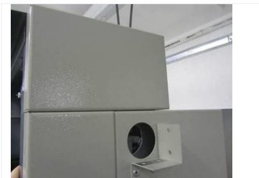
Рис.1.12 Отверстия для прокладки межсекционных связей
