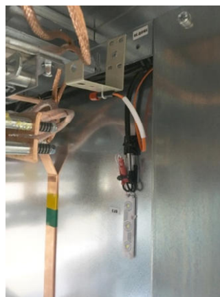
Рис. 1.51 Оптический датчик в отсеке присоединений
