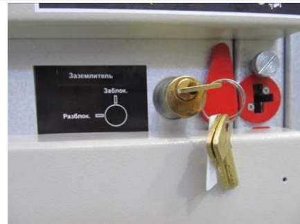
Рис. 2.7 Замковая блокировка □Z
