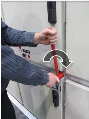
Рис. 2.8 Размещение рычага оперирования заземлителем
