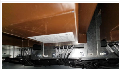
Рис.3.10 Крепление трансформаторов тока
