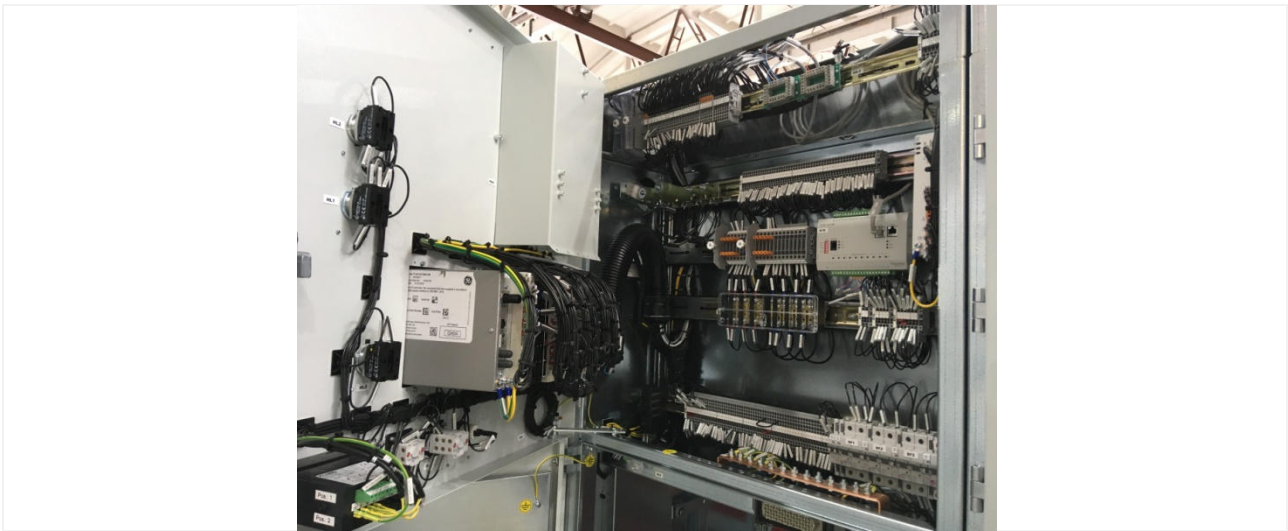
Рис.1.11 Отсек вспомогательных цепей (вид при открытой двери)
