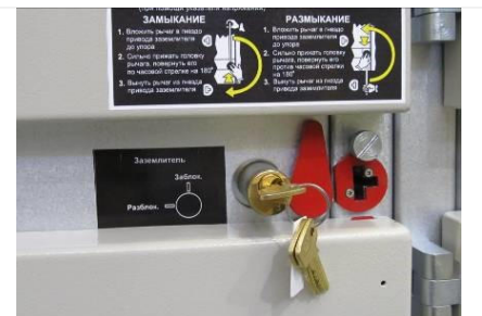
Рис. 1.39 Замковая блокировка оперирования заземлителем
