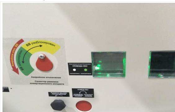
Рис. 2.33 Индикация электромагнитной блокировки
