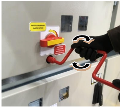
Рис. 2.4 Вращение винтовой передачи КВЭ
