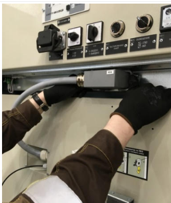
Рис. 2.21 Отсоединение разъема вторичных цепей
