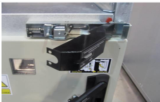
Рис. 2.28 Организация доступа к механизму электромагнитной блокировки
