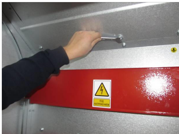
Рис.3.4 Организация доступа в отсек сборных шин с фасада шкафа
