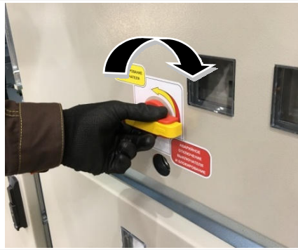
Рис. 2.3 Доступ к гнезду оперирования КВЭ
