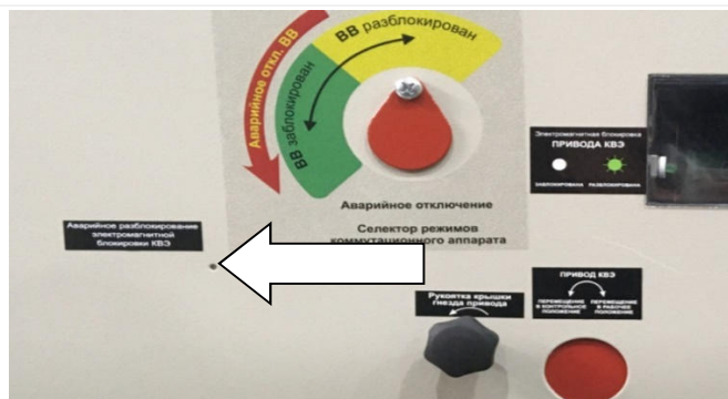
Рис. 2.32 Расположение блокировки отверстия для аварийного отключения электромагнитной блокировки
