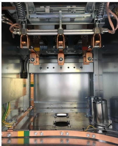
Рис.1.7 Отсек присоединений
