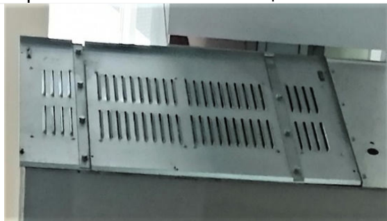
Рис.3 Клапаны сброса давления
