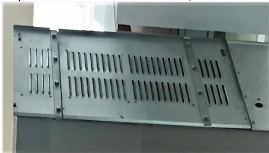
Рис.3 Клапаны сброса давления
