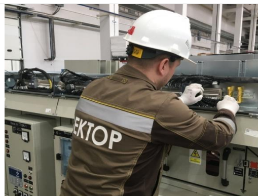
Рис.1.8 Прокладка транзитных цепей
