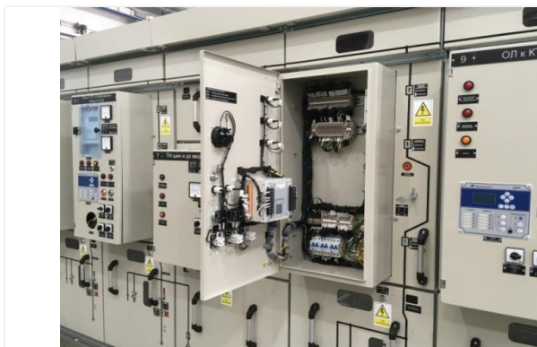
Рис.1.7 Релейный отсек
