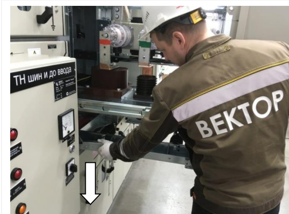
Рис. 2.23 Перемещение моноблока в положение технического обслуживания
