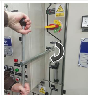
Рис. 2.34 Поворот рычага переключения
