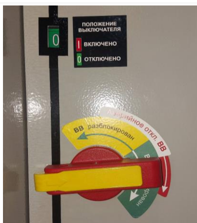
А) выключатель отключен и заблокирован
