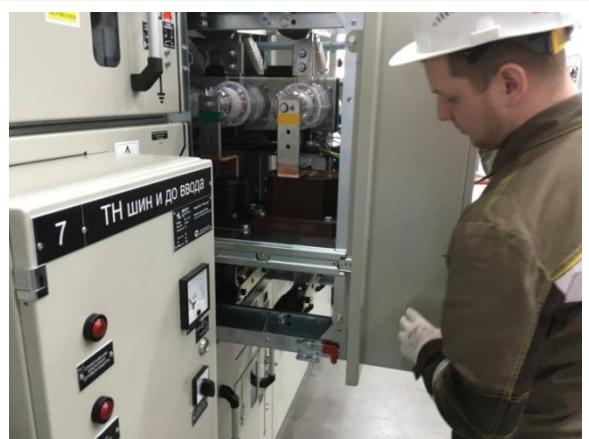
Рис. 2.23 Перемещение моноблока в положение технического обслуживания
