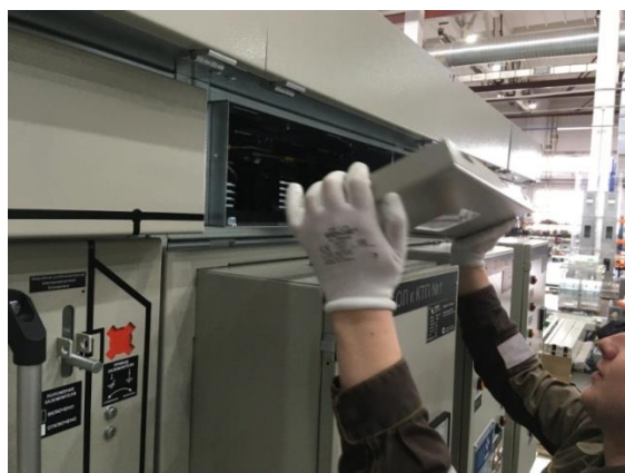
Рис. 2.27 Порядок организации доступа в отсек сборных шин
