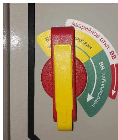
Б) выключатель разблокирован
