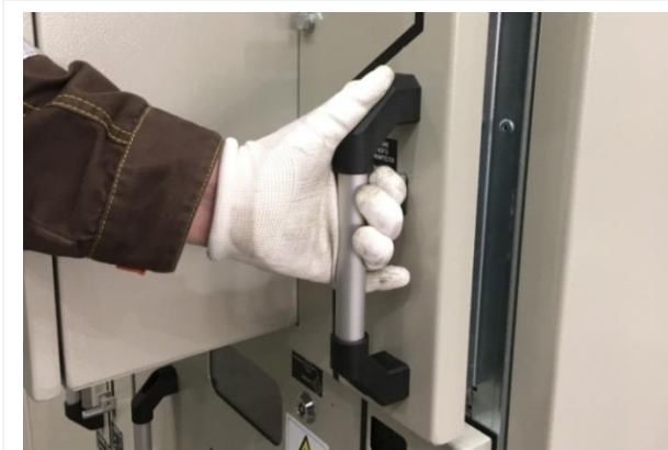
Рис. 2.22 Перемещение моноблока в положение технического обслуживания
