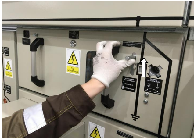
Рис. 2.12 Перемещение ручки заслонки вверх
