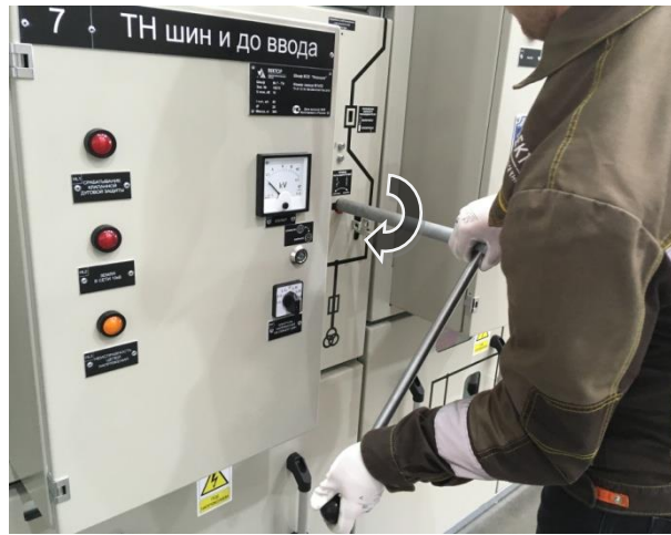
Рис. 2.18 Поворот рычага переключения
