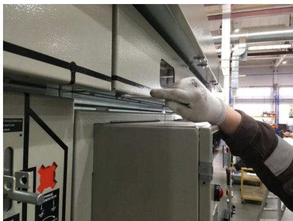
Рис. 2.26 Крышка отсека сборных шин
