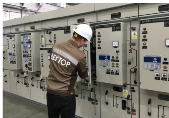
Рис. 2.22 Перемещение моноблока в положение технического обслуживания
