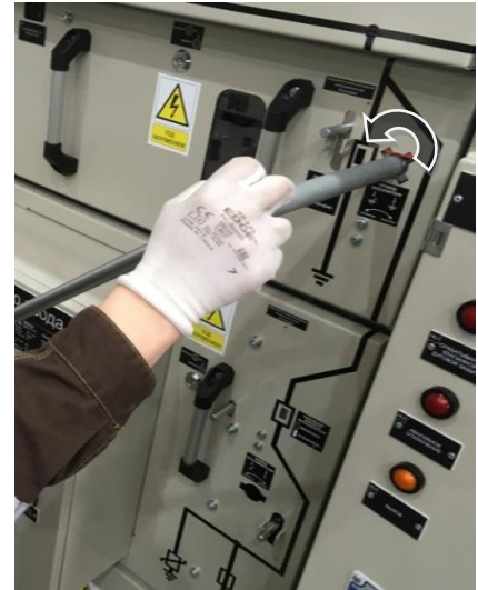
Рис. 2.40 Поворот рычага переключения
