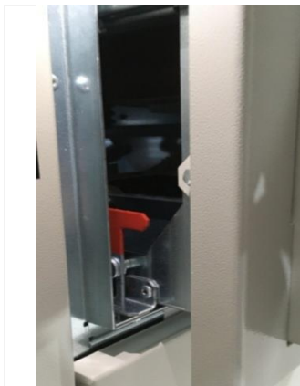
Рис.1.3 Контрольное положение моноблока
