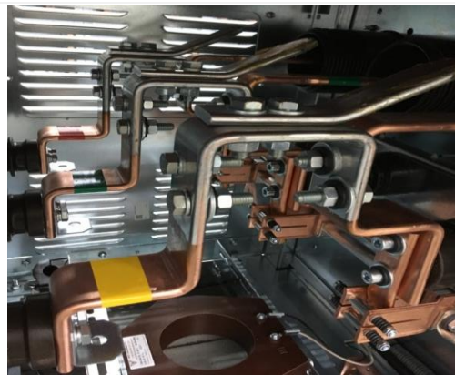
Рис.1.6 Отсек присоединений
