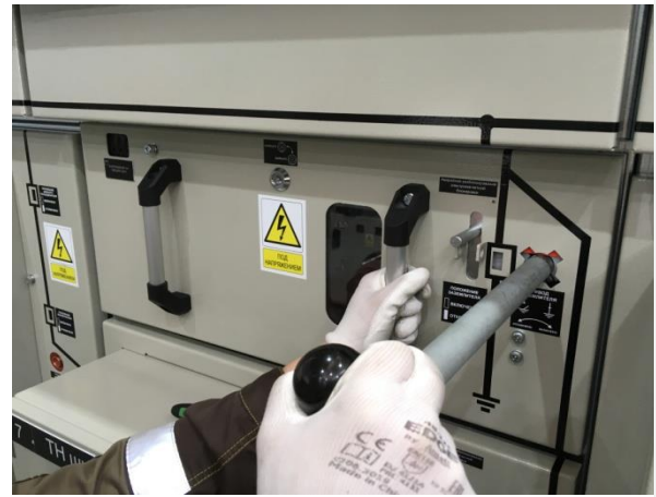
Рис. 2.13 Размещение рычага переключения заземлителя
