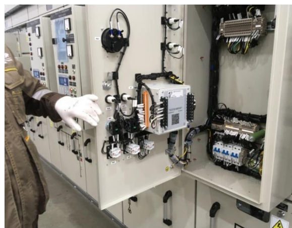
Рис. 2.28 Порядок организации доступа в отсек РЗиА
