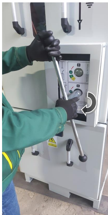
Рис. 2.29 Отключение заземлителя
