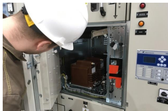
Рис. 2.21 Доступ в отсек ТН
