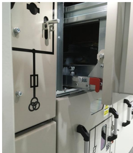
Рис.2.25 Разрешено перемещение моноблока в рабочее положение
