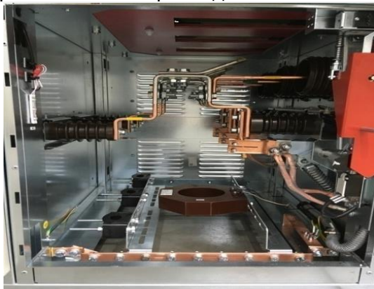
Рис.1.6 Отсек присоединений
