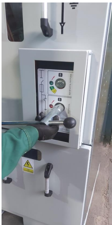
Рис. 2.29 Отключение заземлителя
