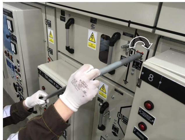
Рис. 2.14 Поворот рычага переключения
