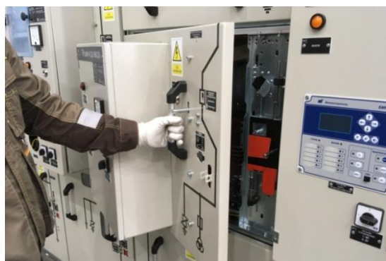
Рис. 2.21 Доступ в отсек ТН
