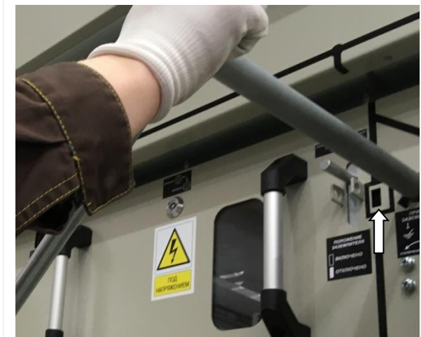
Рис. 2.15 Индикация положения заземлителя
