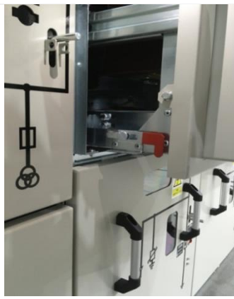
Рис.1.4 Разрешено перемещение моноблока в рабочее положение
