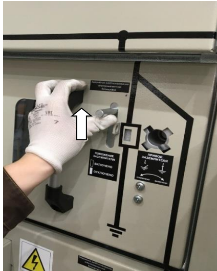
Рис. 2.39 Перемещение ручки заслонки вверх
