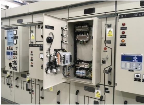
Рис. 5 Релейный отсек
