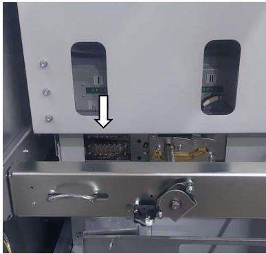
Рис. 14 Концевые выключатели на ВЭ
