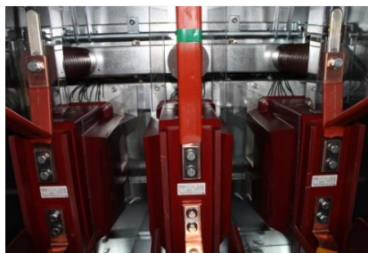
Рис. 6 Отсек присоединений НССШ
