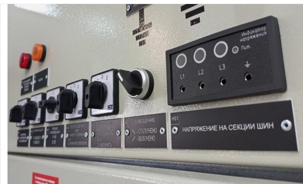
Рис.11 Индикатор наличия напряжения
